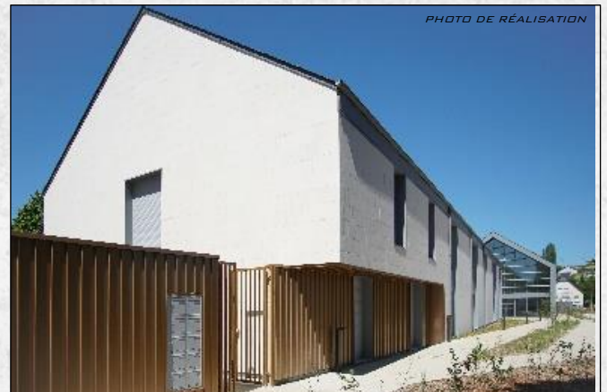
PHOTO DE RÉALISATION
