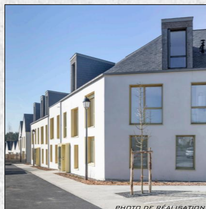
PHOTO DE RÉALISATION
