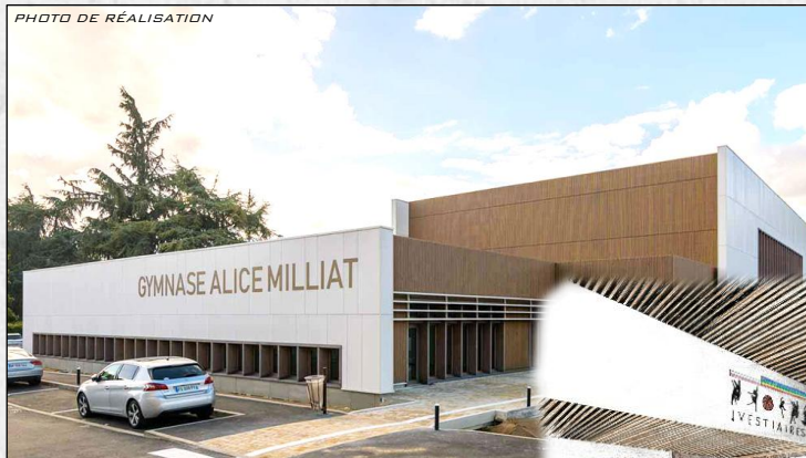
PHOTO DE RÉALISATION
