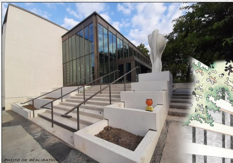
PHOTO DE RÉALISATION
