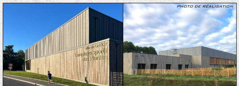
PHOTO DE RÉALISATION
