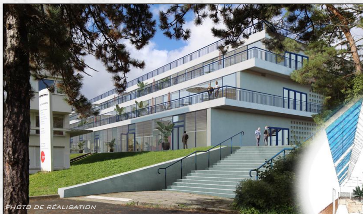
PHOTO DE RÉALISATION
